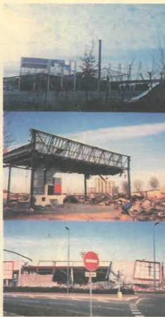
Zone commerciale détruite avant le pont de l'ONIA, le long de la route d'Espagne
