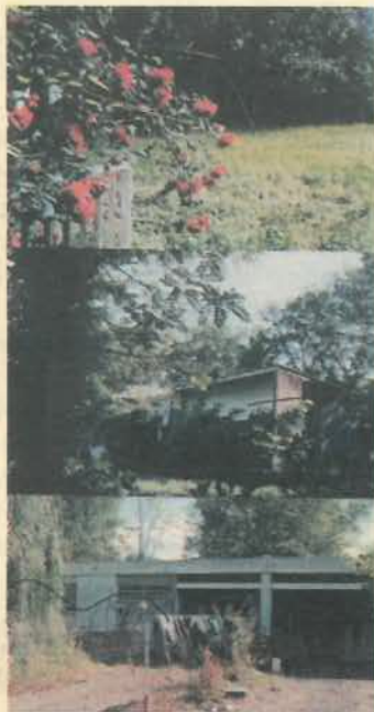
Maisons envahies par la végétation Maison détruite habitée
