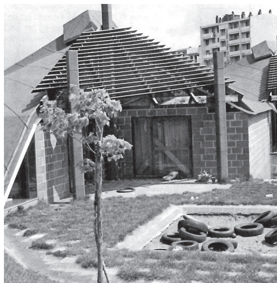
Aire de jeux de la crèche et avertisseurs brise-soleil, à Empalot. © J.P. Cordier, C. Sarramon, D. Amouroux
