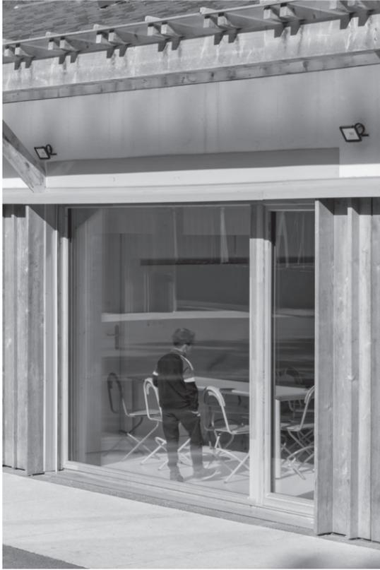
Hormis les menuiseries et les grands éléments C24 en lamellé-collé importés d'Autriche, tout le reste de la structure et du bardage provient de coupes et d'un usinage réalisés dans le Sud-Ouest, notamment sur le territoire de Girac dans le Lot ainsi que des forêts du Gers.
