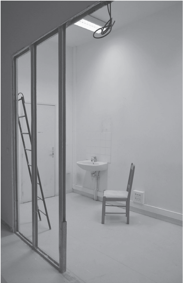
Action. Le processus de projet est simple, et se veut non interventionniste. On vient ôter le superflu, en accordant une attention au déjà là. Ici, la cloison est découpée et les rails deviendront un support d'accrochage pour le futur salon de coiffure.
