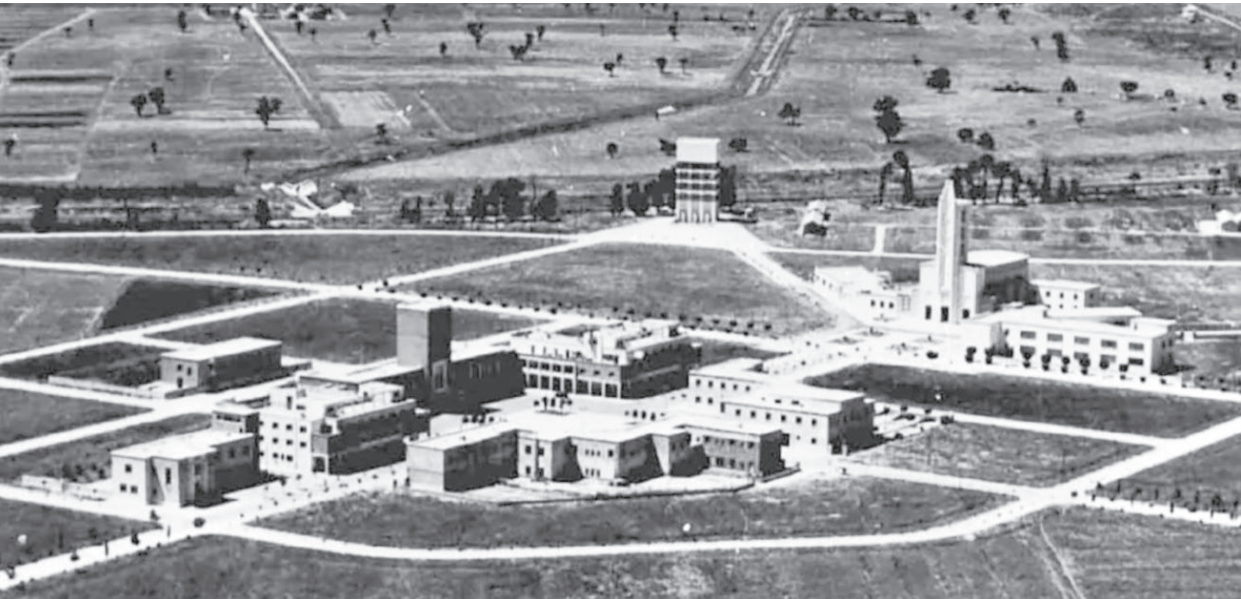
Le centre de Pontinia en construction, 1939. (Source : Stato Maggiore Aeronautica, n. cat. 45948).
