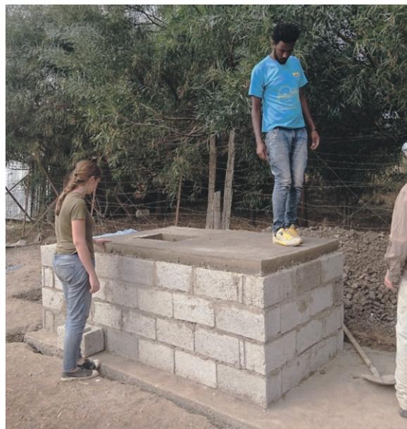
(photo 7) Une deuxième dalle de béton recouvre un soubassement en parpaings pour former la base du sanitaire.
