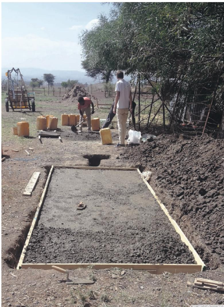
(photo 6) Un dernier mélange de béton est préparé manuellement pour finir de couler le dallage.
