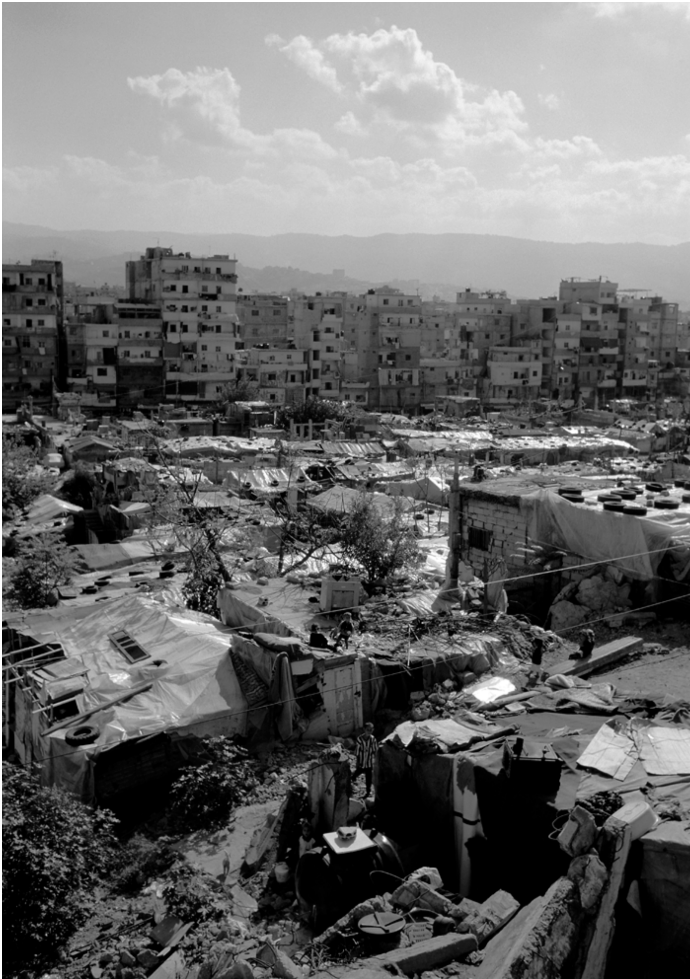
Une vue générale du camp de Chatila. Le camp « officiel » de l'UNRWA ceinturé par des bidonvilles à l'ouest et au sud, comprend 40 000 mètres carrés de constructions en béton. Au premier plan, camp des « Nourieh » (Tsiganes), en contre-bas de la cité sportive de Beyrouth. Les habitations sont faites de tôle ondulée, de bouts de bois et de bâches en plastique. Parfois, c'est un vieux canapé qui maintient le toit improvisé, mais le plus souvent, ce sont de vieux pneus ou des pierres qui font office de poids. ©Tarek Charara/Kaleidos
