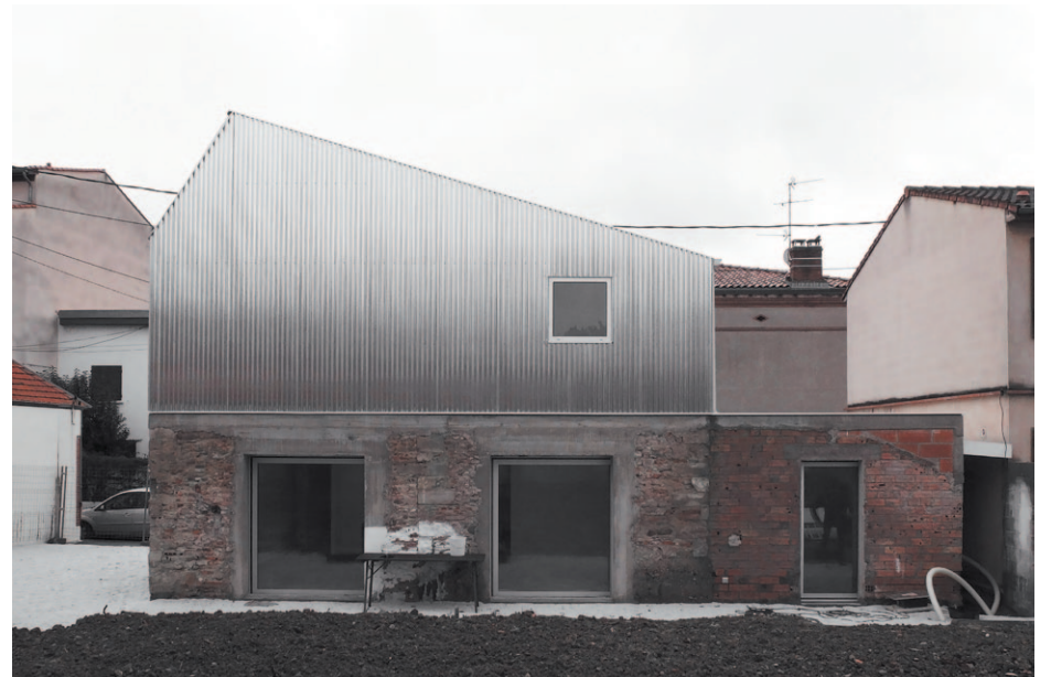
M03 surélévation d'une maison de faubourg, 120m 2 , Toulouse (31), 2013
