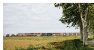
COLLÈGE JOSEPH REY Arotcharen et Deligny architectes Cadours (31) - 2012 - © S. Deligny
