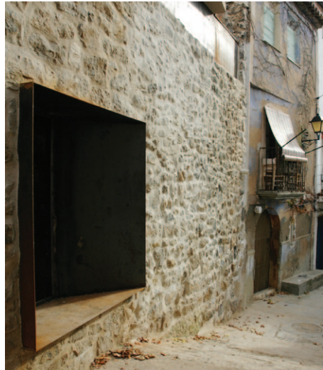
Reforma y ampliación de locales anexos al Museo Etnológico C/ Soldevilla, 25 y c/ La Muela s/n - Nonaspe (Zaragoza)
