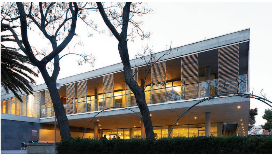
Edificio de Servicios Generales en Centro Natación Helios Arboleda Macanaz, s/n - Zaragoza
