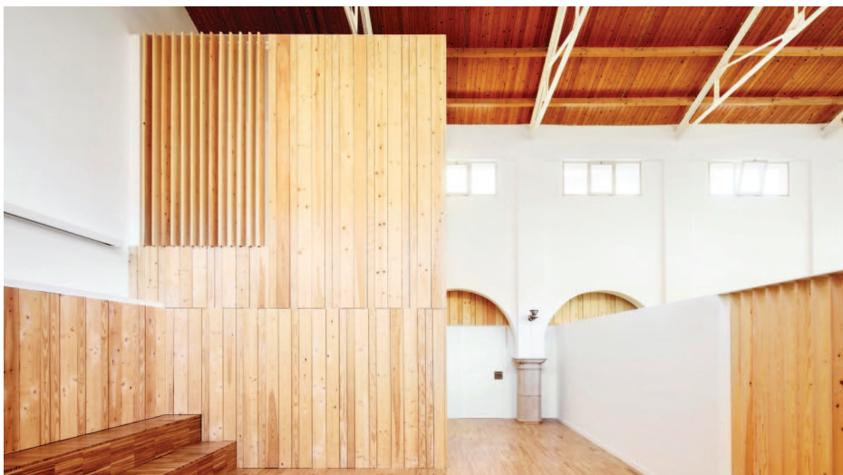
Reforma interior de adecuación de antiguo Mercado de Abastos de Alcañiz como Centro Cívico y de ocio infantil Plaza del Mercado, s/n - Alcañiz (Teruel)
