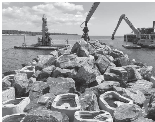
Récif bas en construction, juin 2022. Au premier plan, des mares résiduelles en béton écologique. © SCAPE
