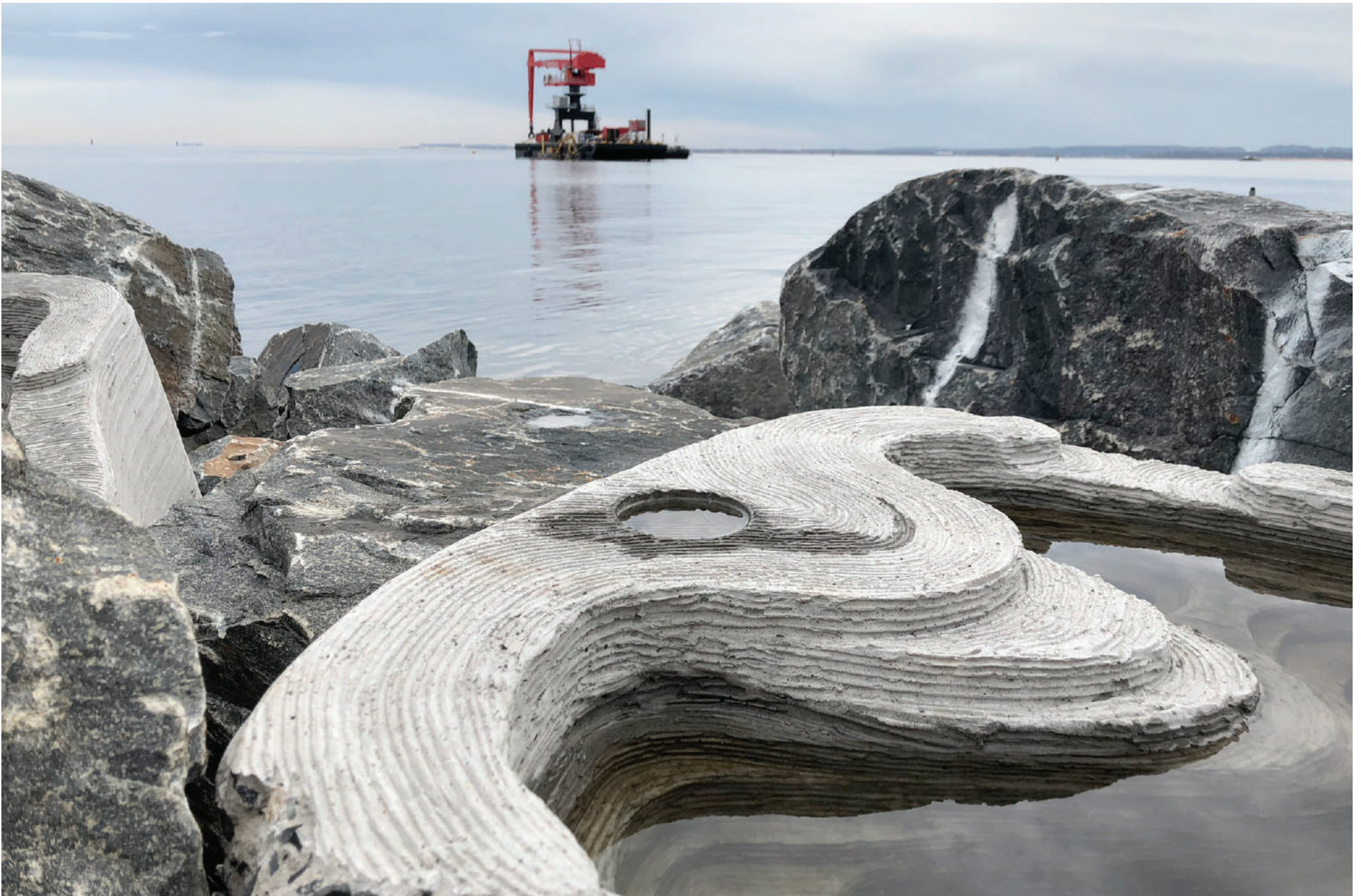
L'un des récifs, avec une cuvette pour les marées. Au loin, la construction des autres récifs. Mars 2021. © SCAPE
