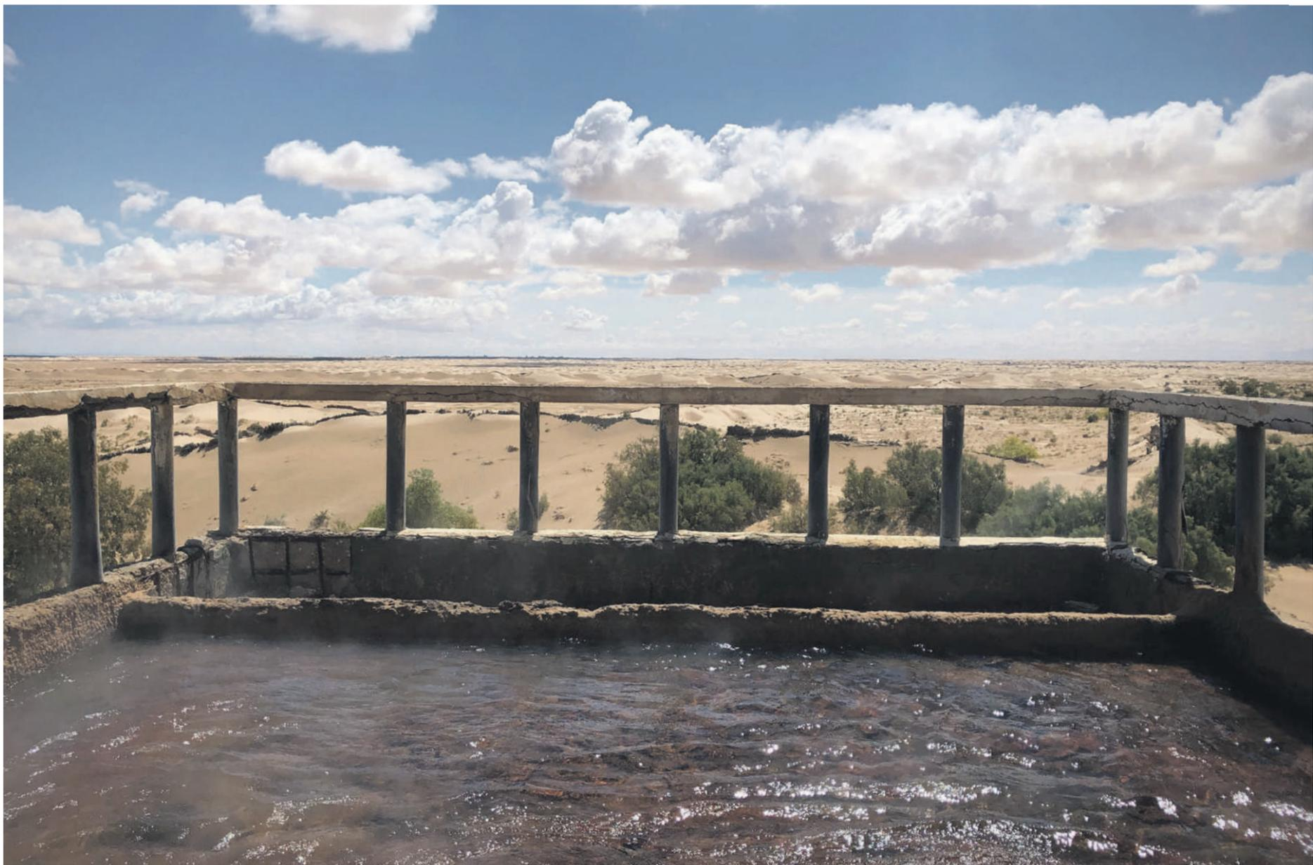
Puisée jusqu'à 1000m de profondeur l'eau est conduite jusqu'au toit de l'édifice.
