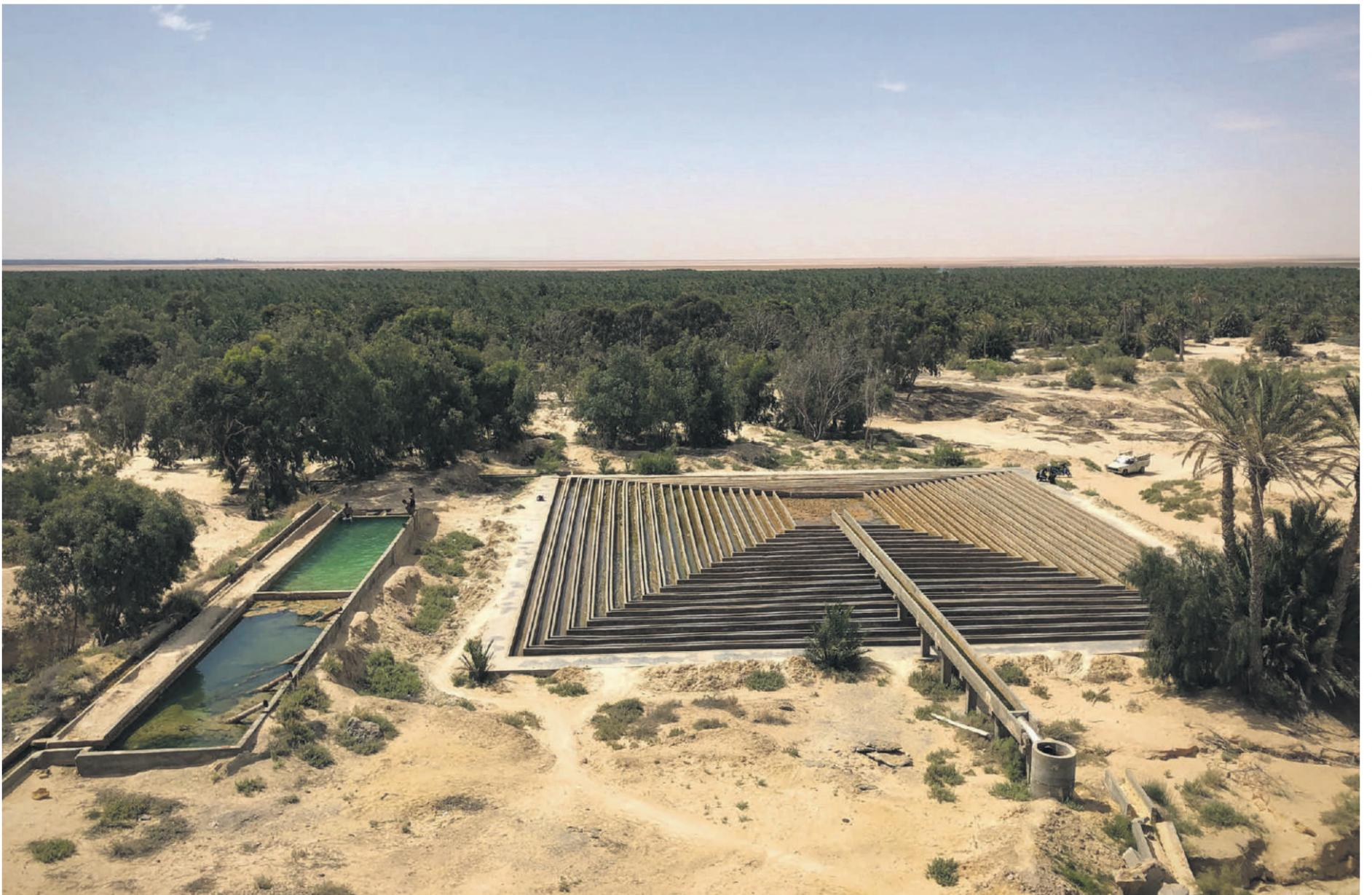
L'eau finira de se refroidir lors d'un long parcours dans ces pyramides quasiment plates avant d'être acheminée par des canaux vers les palmeraies.
