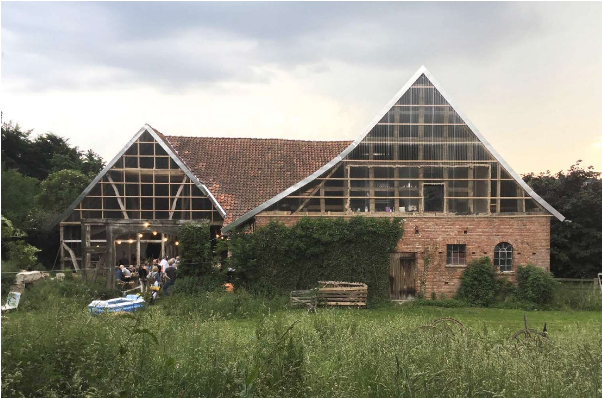
Transformation d'une ferme en espace artistique et culturel, Atelier Fanelsa, Pohle, Germany, 2018.
